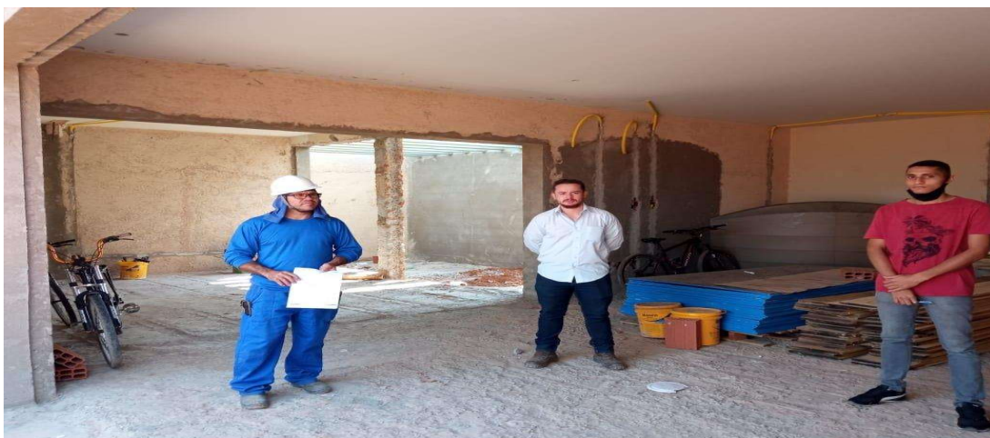
Figura 1: Pesquisa em obra de residência privada
